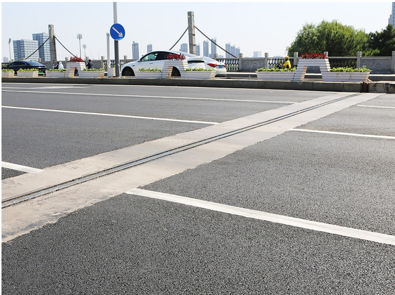
东关大桥、玉带河大桥实施伸缩缝更换“微改造”。记者 冯维静/摄
