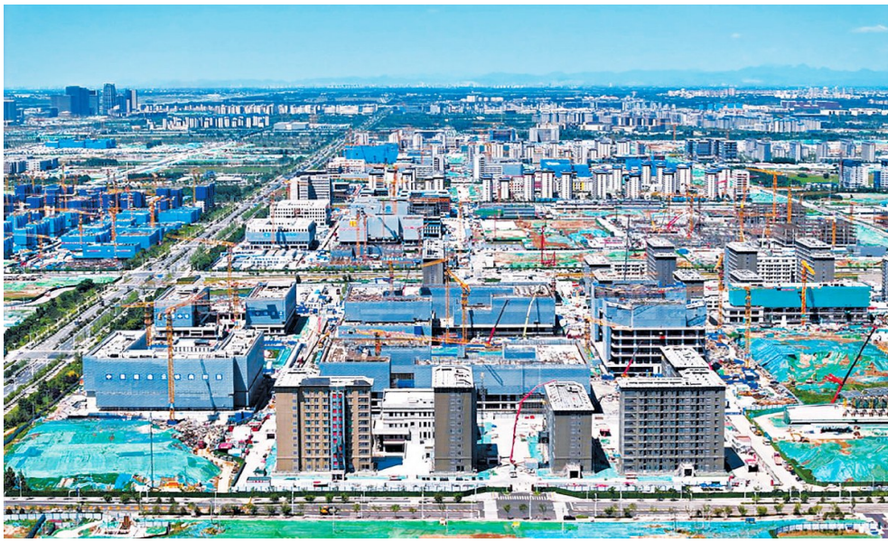
位于雄安新区起步区的首批4所疏解高校雄安校区建设现场。 新华社发
