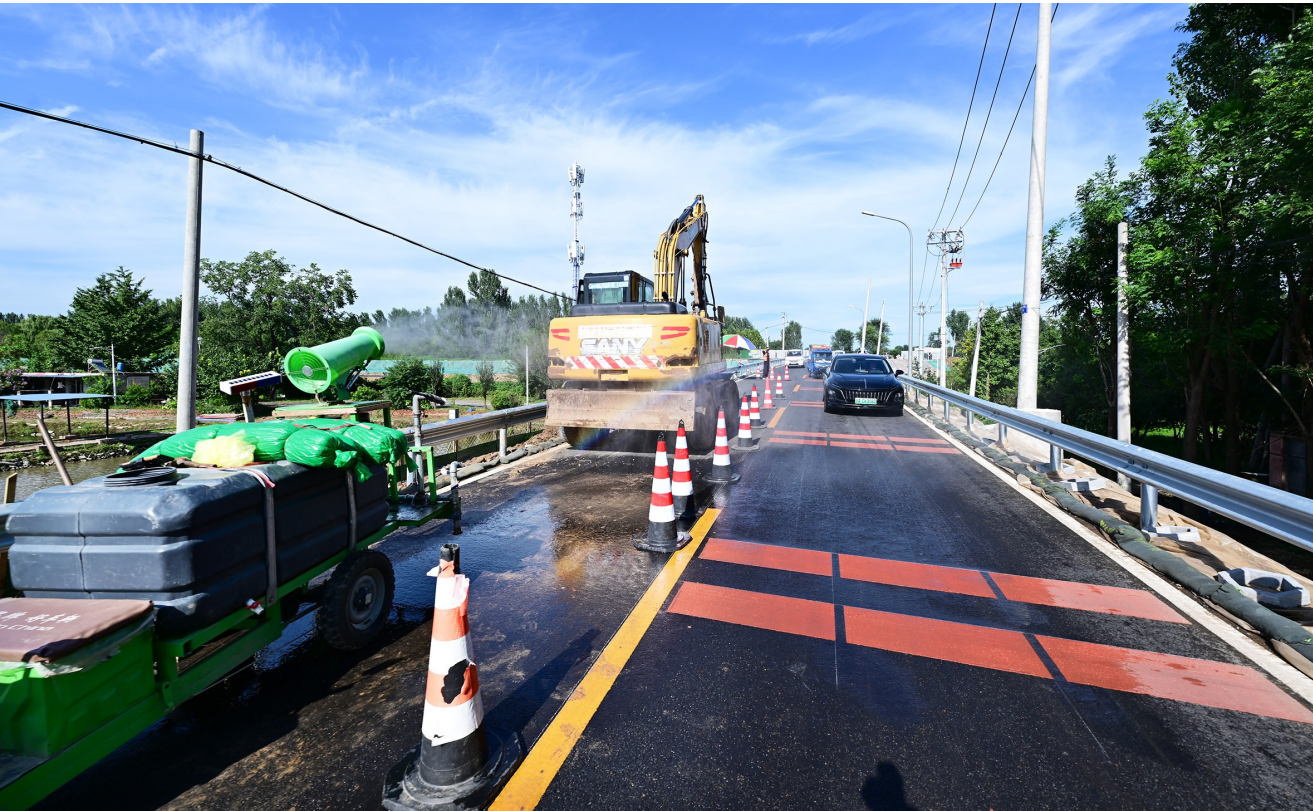
堤防一侧的作业区域,工人们正有条不紊推进收尾加固作业。记者 唐建/摄
