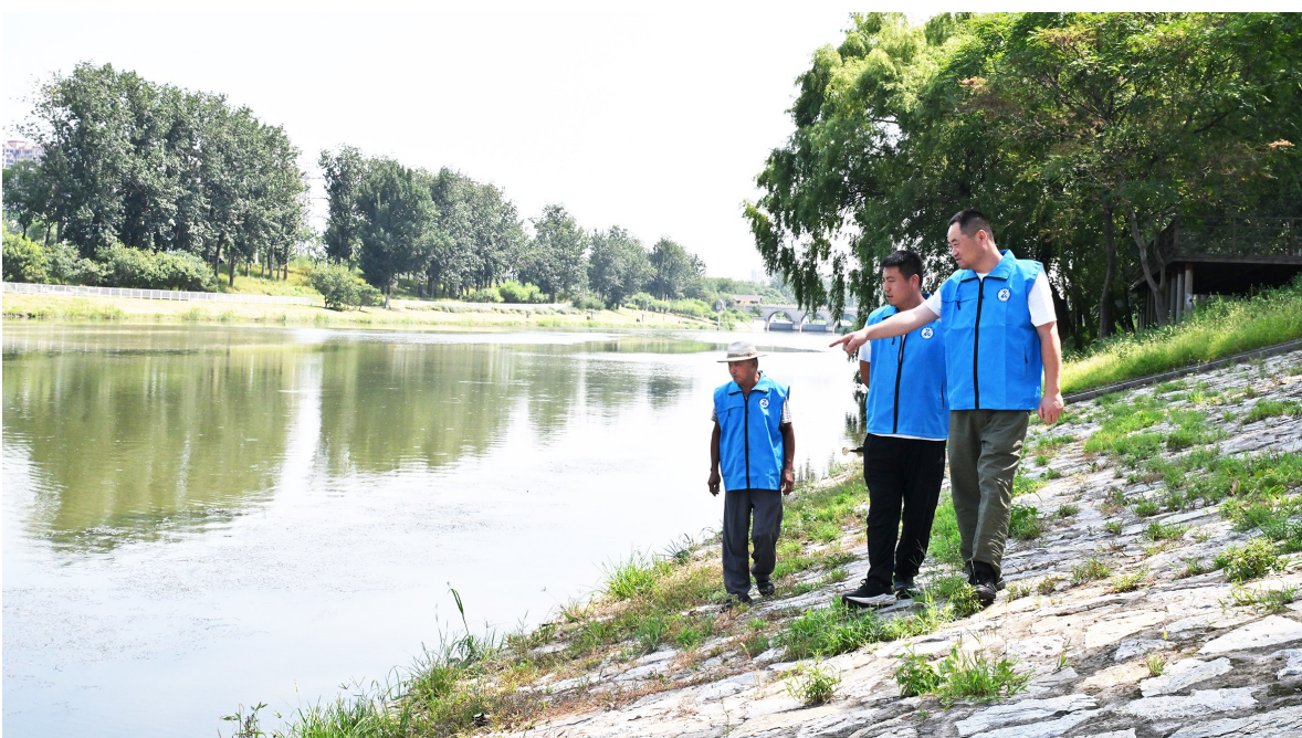
通州水务巡河小组沿堤巡查,拉网排查河道汛期安全隐患。记者 常鸣/摄
