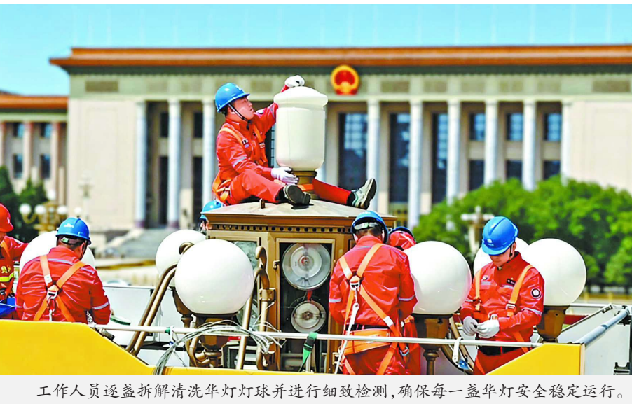
工作人员逐盏拆解清洗华灯灯球并进行细致检测，确保每一盏华灯安全稳定运行。
