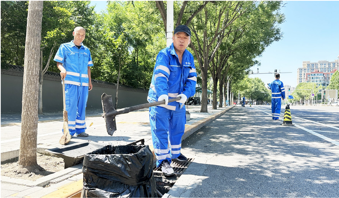
通州区环卫部门开展雨水管网清掏专项行动,全方位消除积水隐患。记者 唐建/摄
