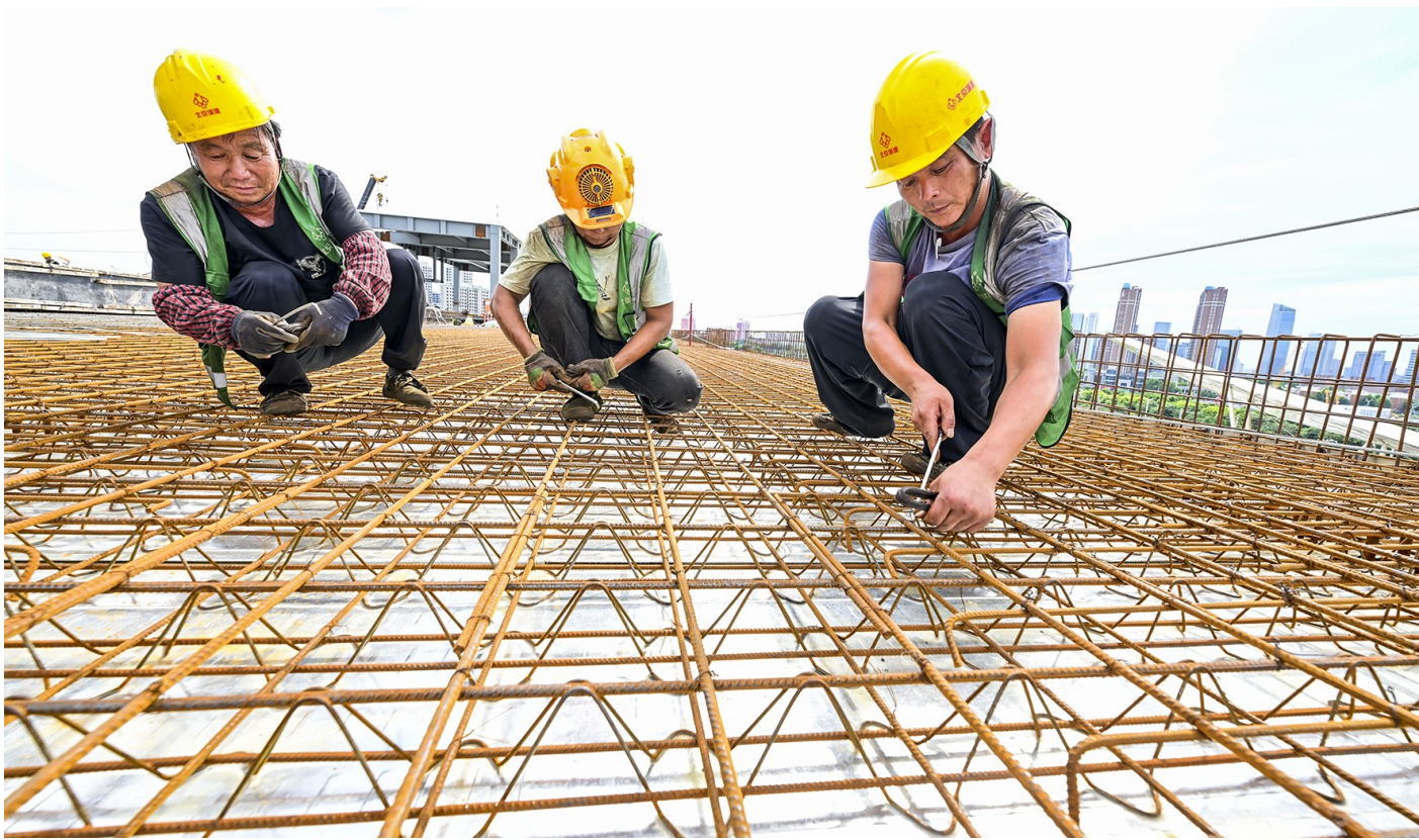
工人们师傅们在烈日下检查刚刚封顶的钢结构。记者 唐建/摄
