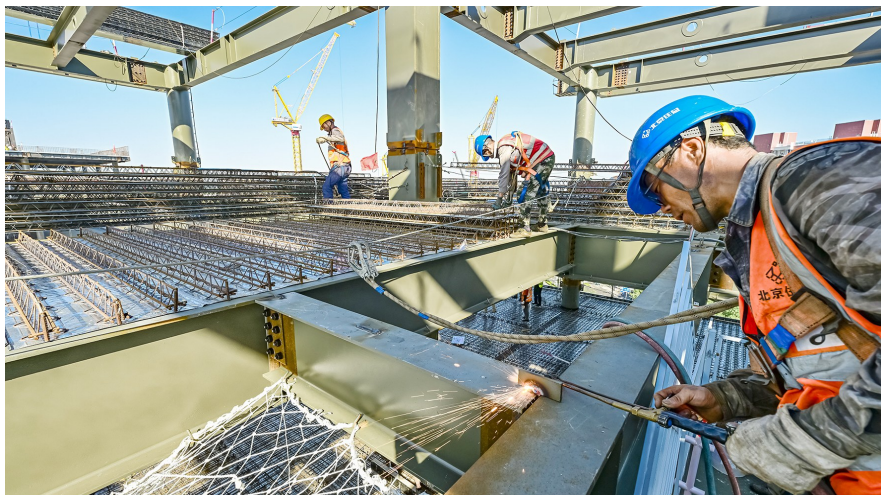
建设者头戴安全帽,手中焊枪不停,全力推进工程进度。记者 唐建/摄
