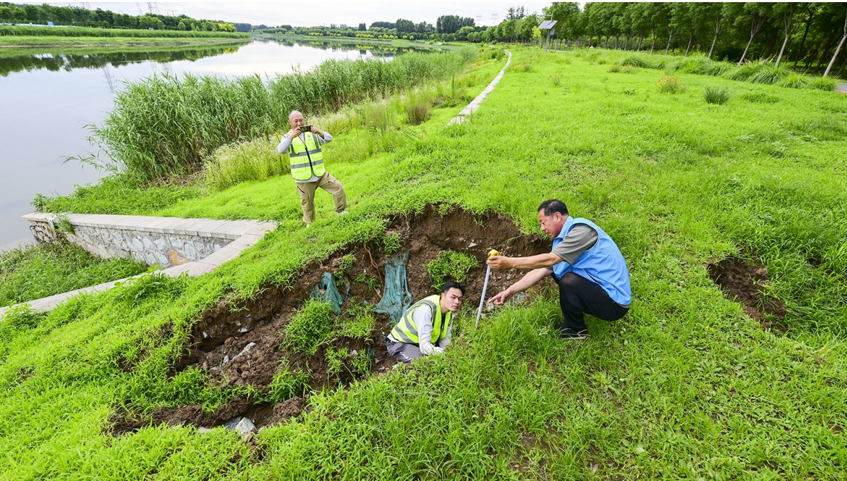
抢抓晴好天气排查河道水毁隐患,精准勘测岸坡塌陷守护河湖安澜。记者 唐建/摄
