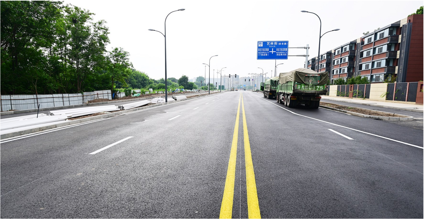
潞苑南一街主路正式放行通车,为城市副中心北部片区高质量发展注入全新活力。记者 唐建/摄
