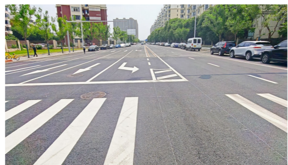
潞苑三街通车,完善片区交通路网。记者 常鸣/摄
