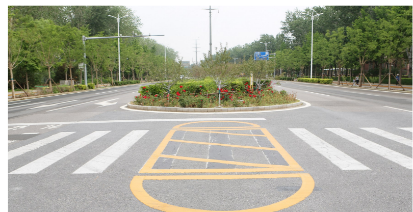
通州区8处重点路口开展适老化专项改造。记者 冯维静/摄
