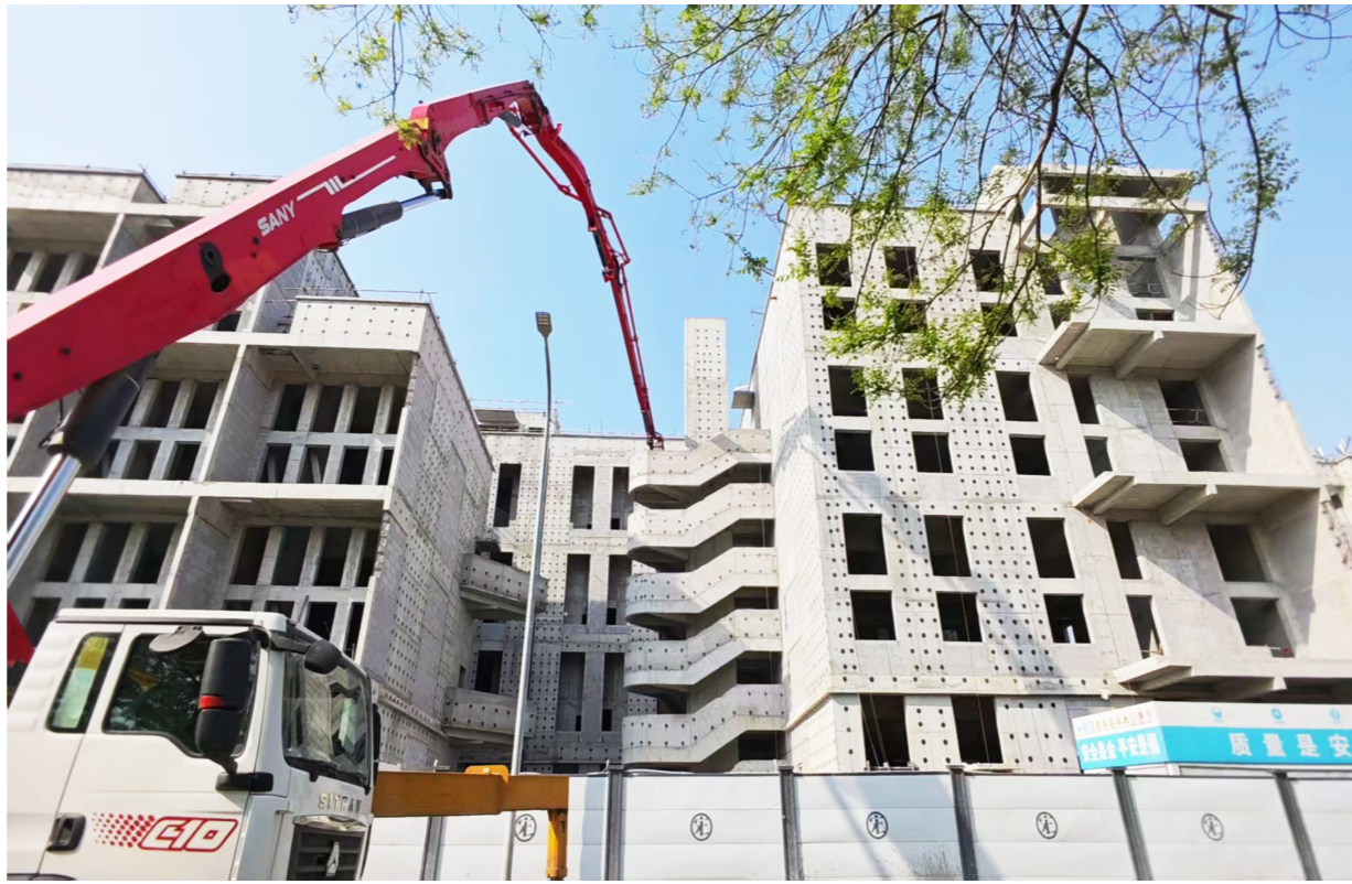
宋庄青年艺术家工坊项目完成主体结构封顶,装饰装修、机电安装正在有序推进。
