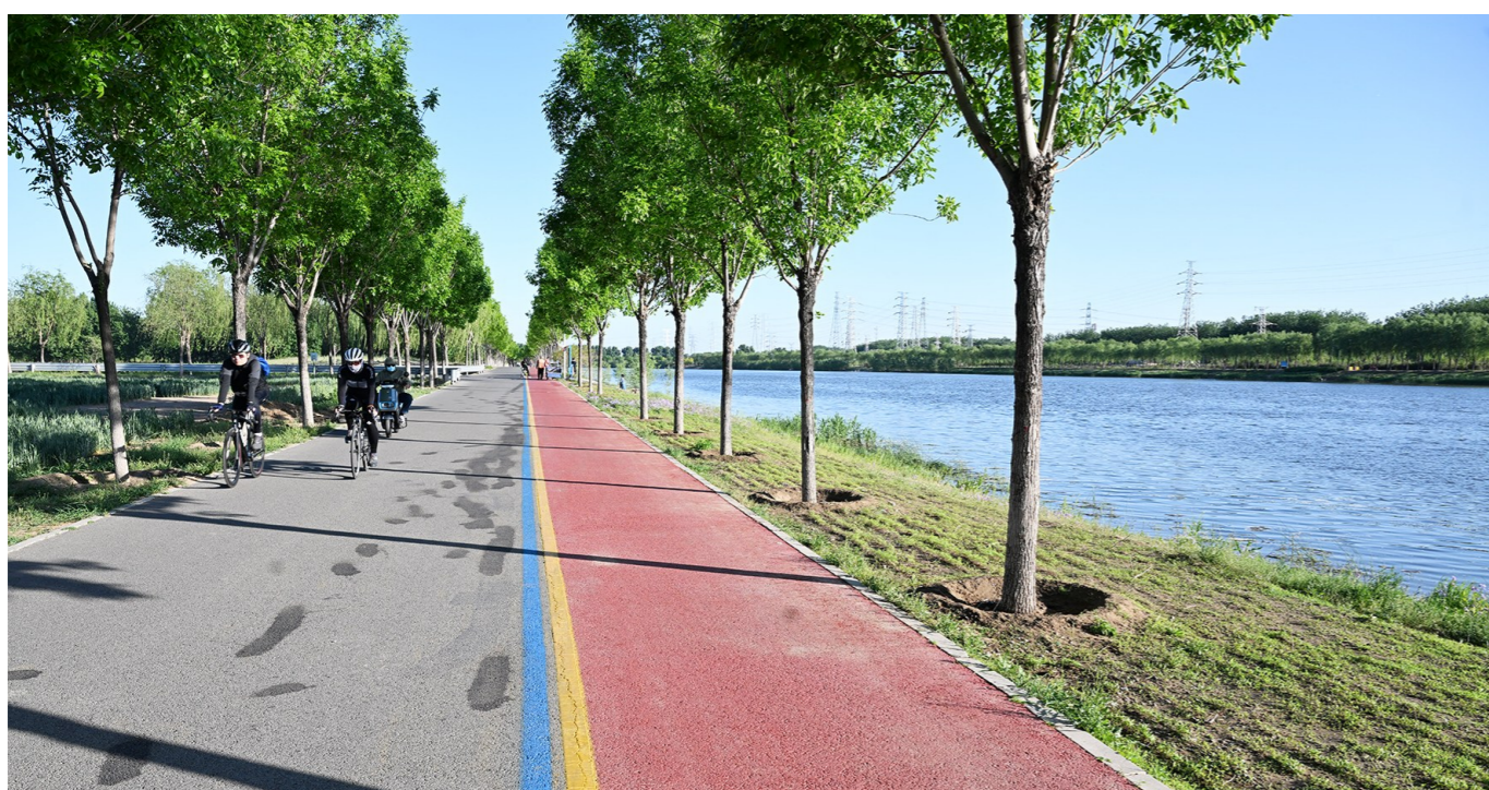
潞城镇一段长约3.7公里的滨水岸线以崭新面貌向市民开放。记者 唐建/摄
