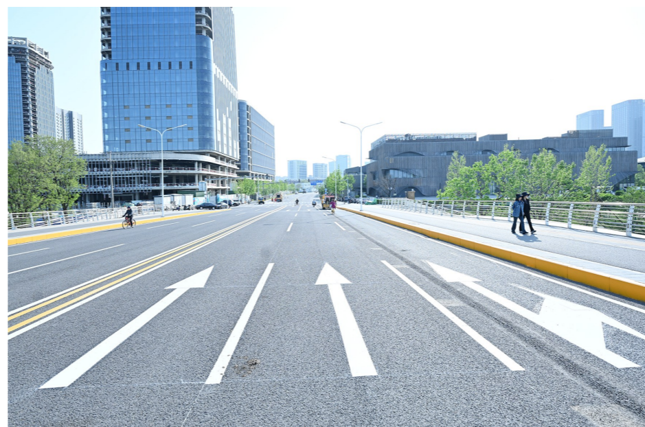
千荷泻露桥道路东延工程安排双向六车道,将于明日正式通车。记者 唐建/摄
