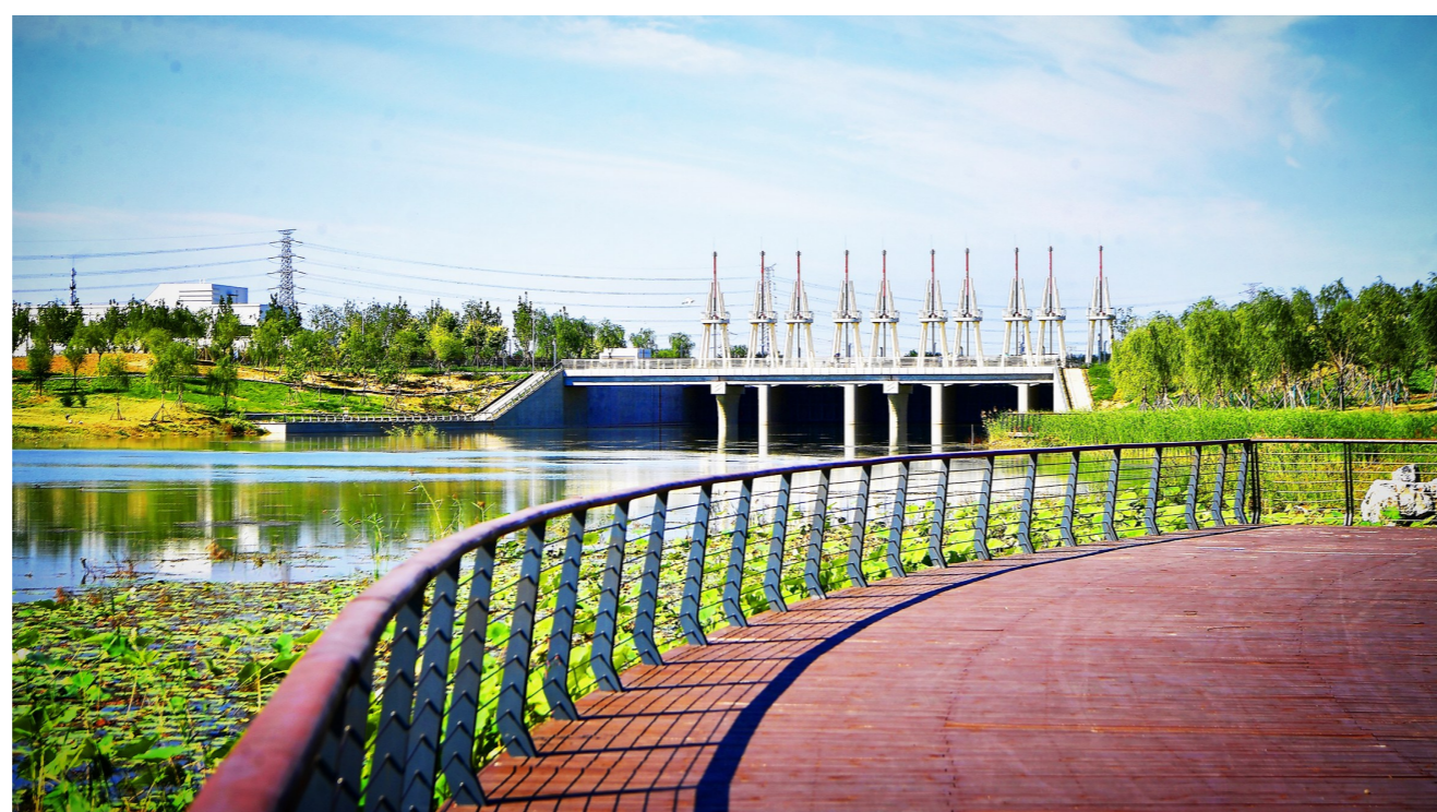
图为宋庄蓄滞洪区。记者 唐建/摄
