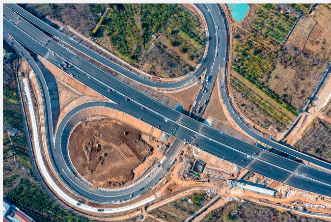
工人测桁架、铺沥青,奋力推动承平高速进入通车冲刺阶段。记者 潘之望/摄
