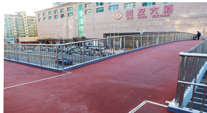
天桥重新铺装防滑地胶，大幅提升通行安全性。记者 冯维静/摄
