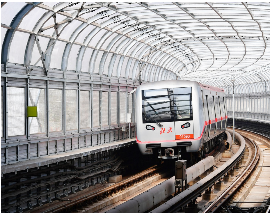
新线开通后,周边居民出行结构将会得到改善,进一步优化城市功能。记者 常鸣/摄
