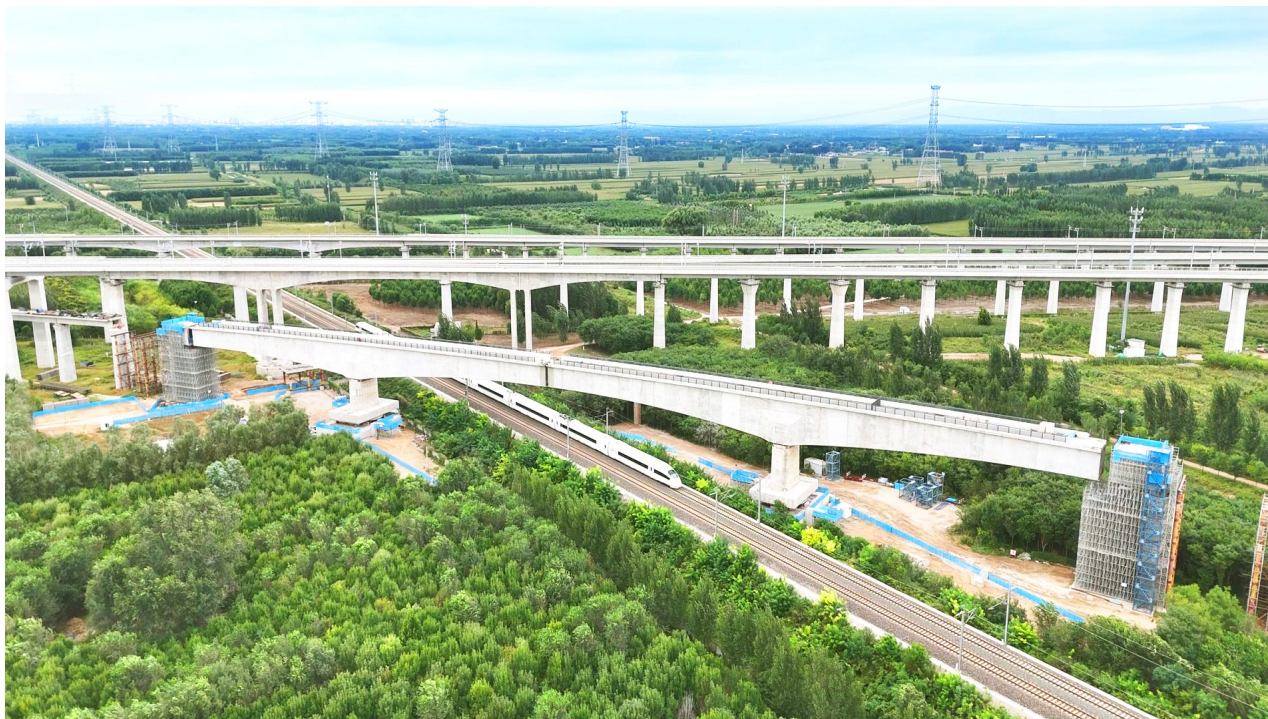
津九上行联络线特大桥连续梁成功转体。
