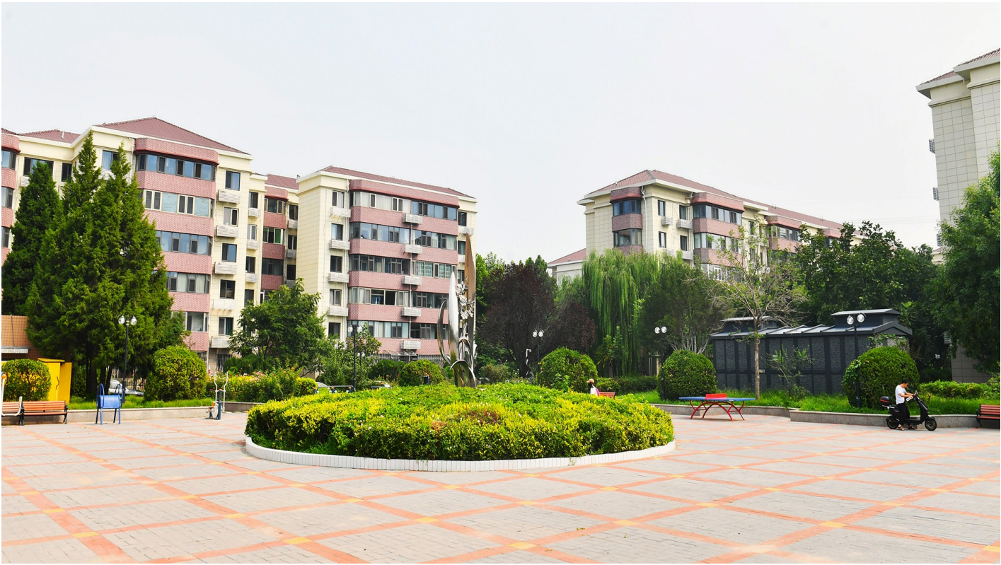
水仙园小区经改造后旧貌换新颜，进一步升级居民幸福感。记者 王戡/摄
