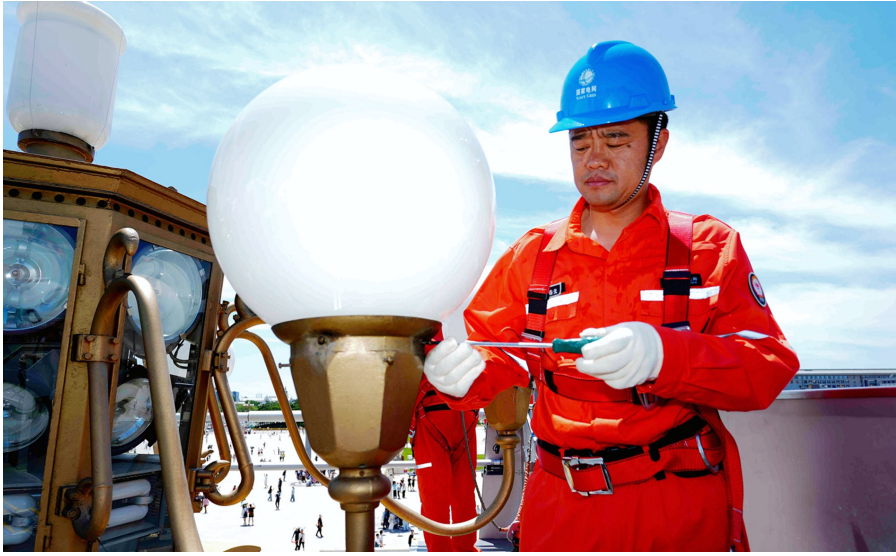
烈日下,工作人员对天安门广场华灯进行清扫检修作业。张超/摄
