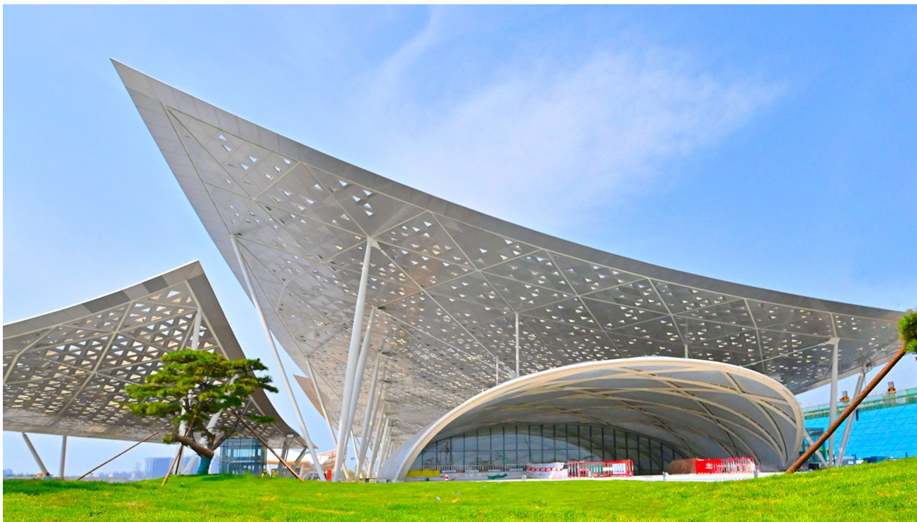
副中心站交通枢纽已完成地面广场铺装和绿化,预计年底建成。记者 常鸣/摄
