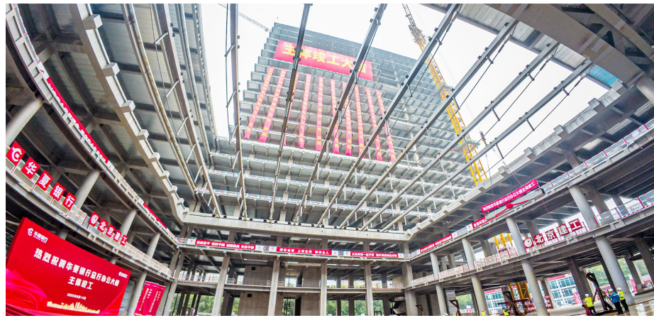
华夏银行总行办公大楼在副中心顺利实现主体结构封顶。记者 潘之望/摄
