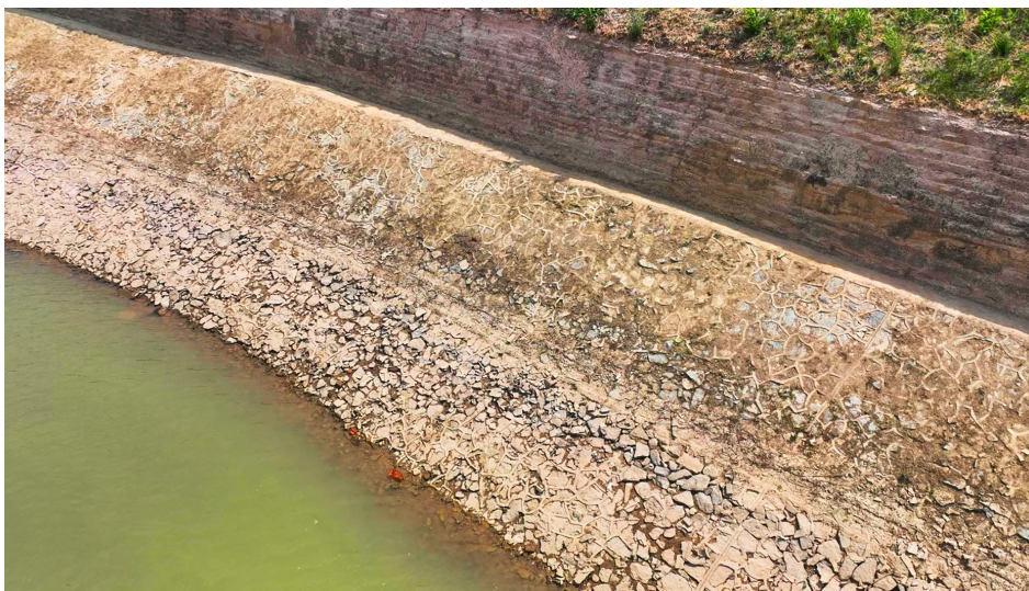
谢家坝坝体厚3.6米、高5米,对防御洪水起重要作用。王雅楠/摄
