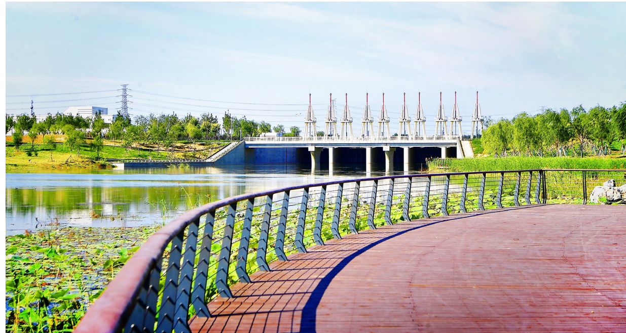
图为宋庄蓄滞洪区,位于温榆河左岸,是“通州堰”分洪体系的重要组成部分。记者 唐建/摄
