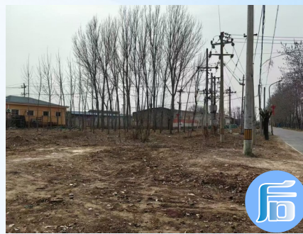
潮县镇东黄堡距石东路约9米,距凤港减河约866米-大型垃圾渣土堆放点复发点位
