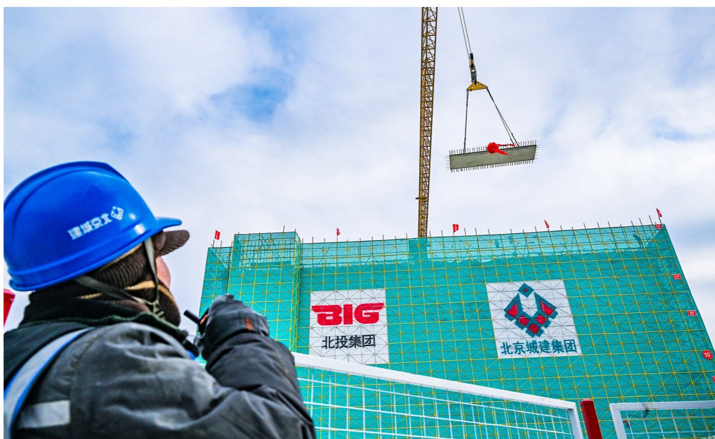
施工团队严格遵循施工标准,确保工程高效推进。记者 常鸣摄
