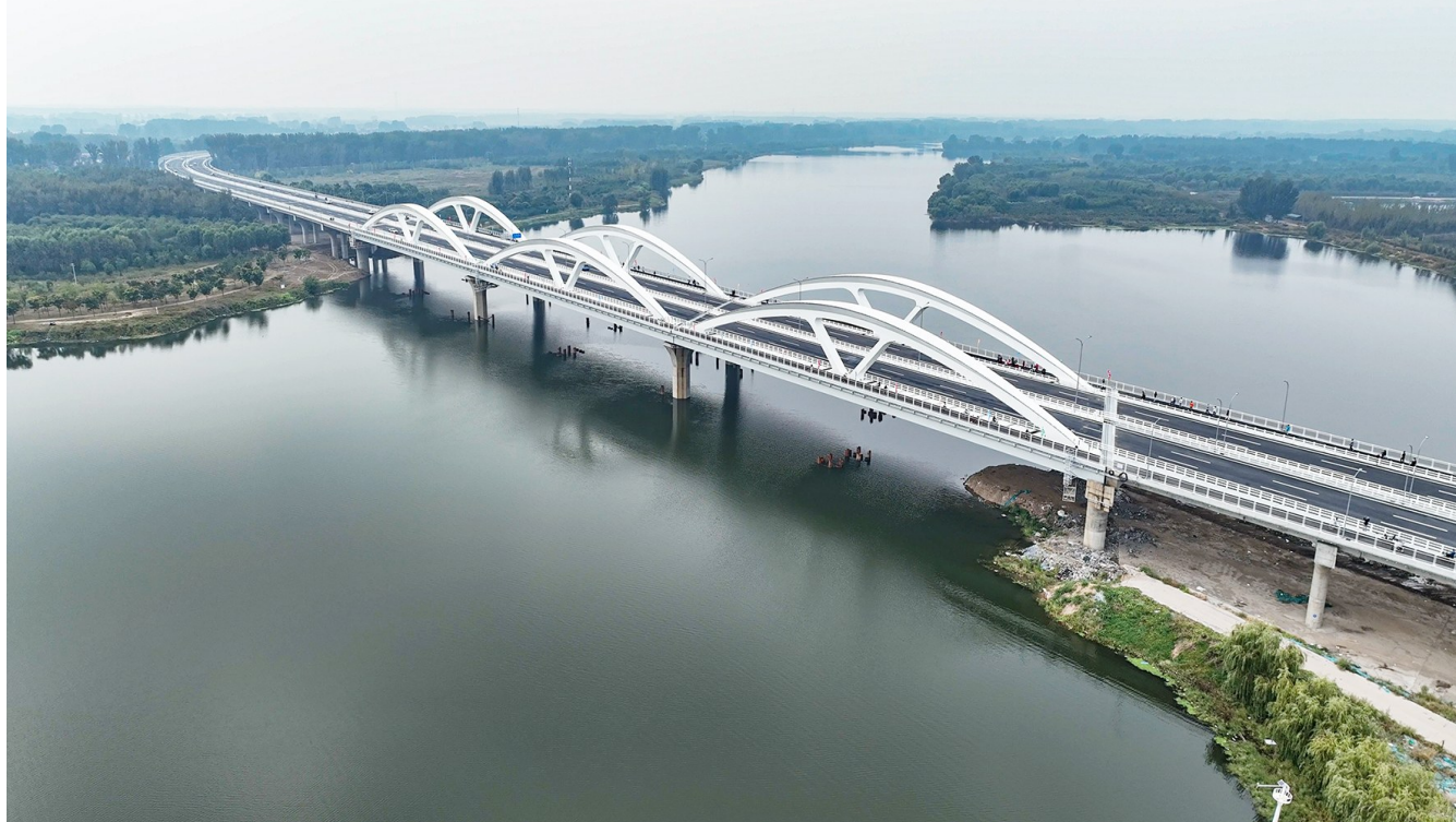
厂通路潮白河大桥去年正式通车，两岸居民通勤时间大幅缩短。记者 常鸣/摄
