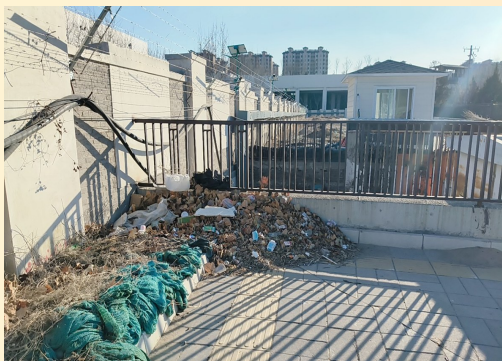
潞城镇清韵南路与大营东一街交叉口南侧-积存垃圾
