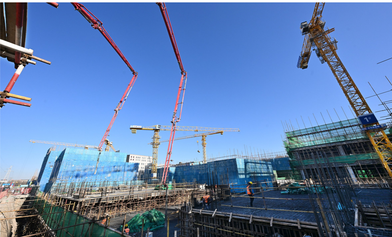
施工现场热火朝天，工人正在进行混凝土浇筑作业。记者 常鸣/摄
