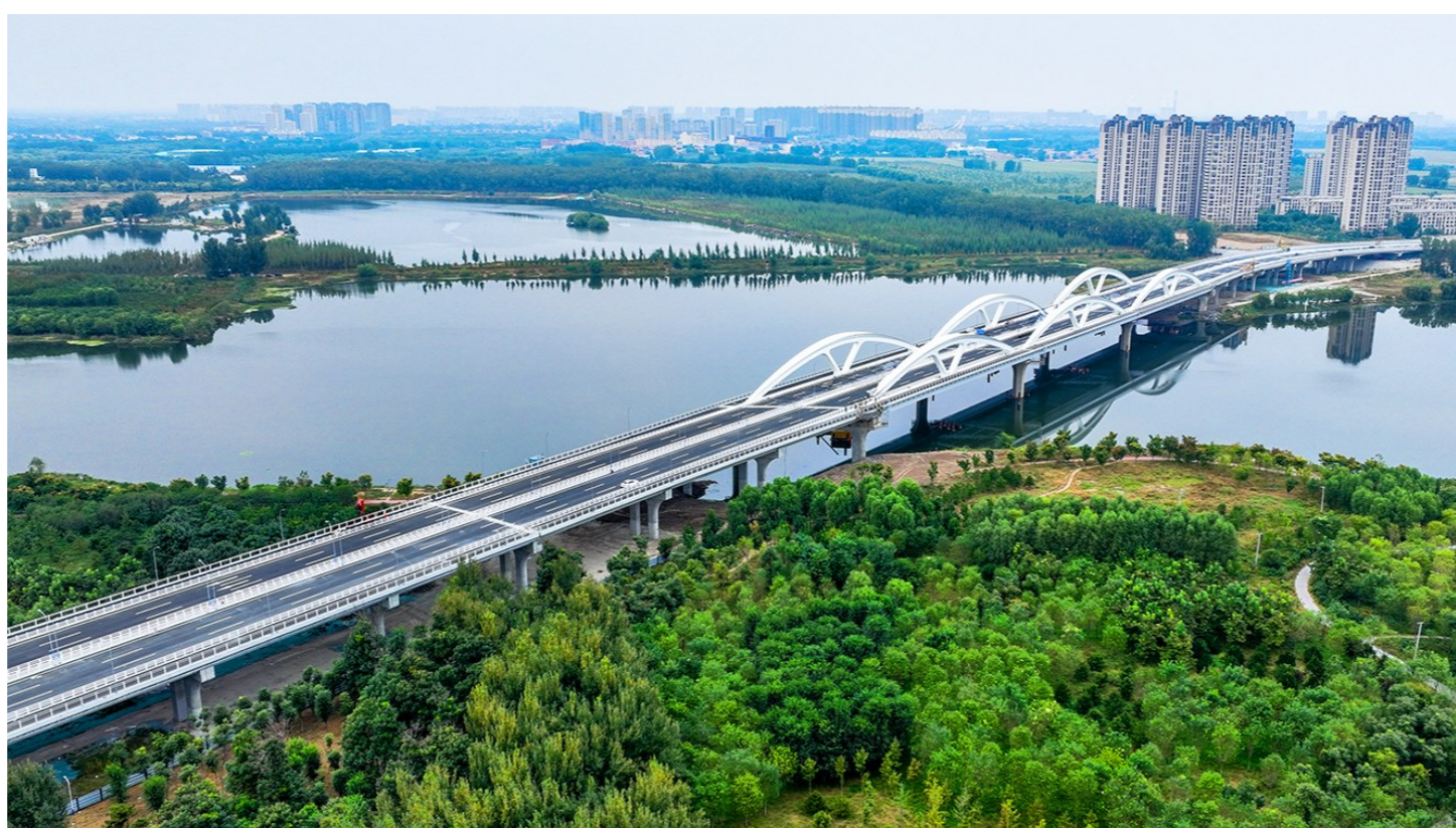
厂通路潮白河大桥为京冀两地提供了一条方便快捷的直连通道。记者 常鸣/摄
