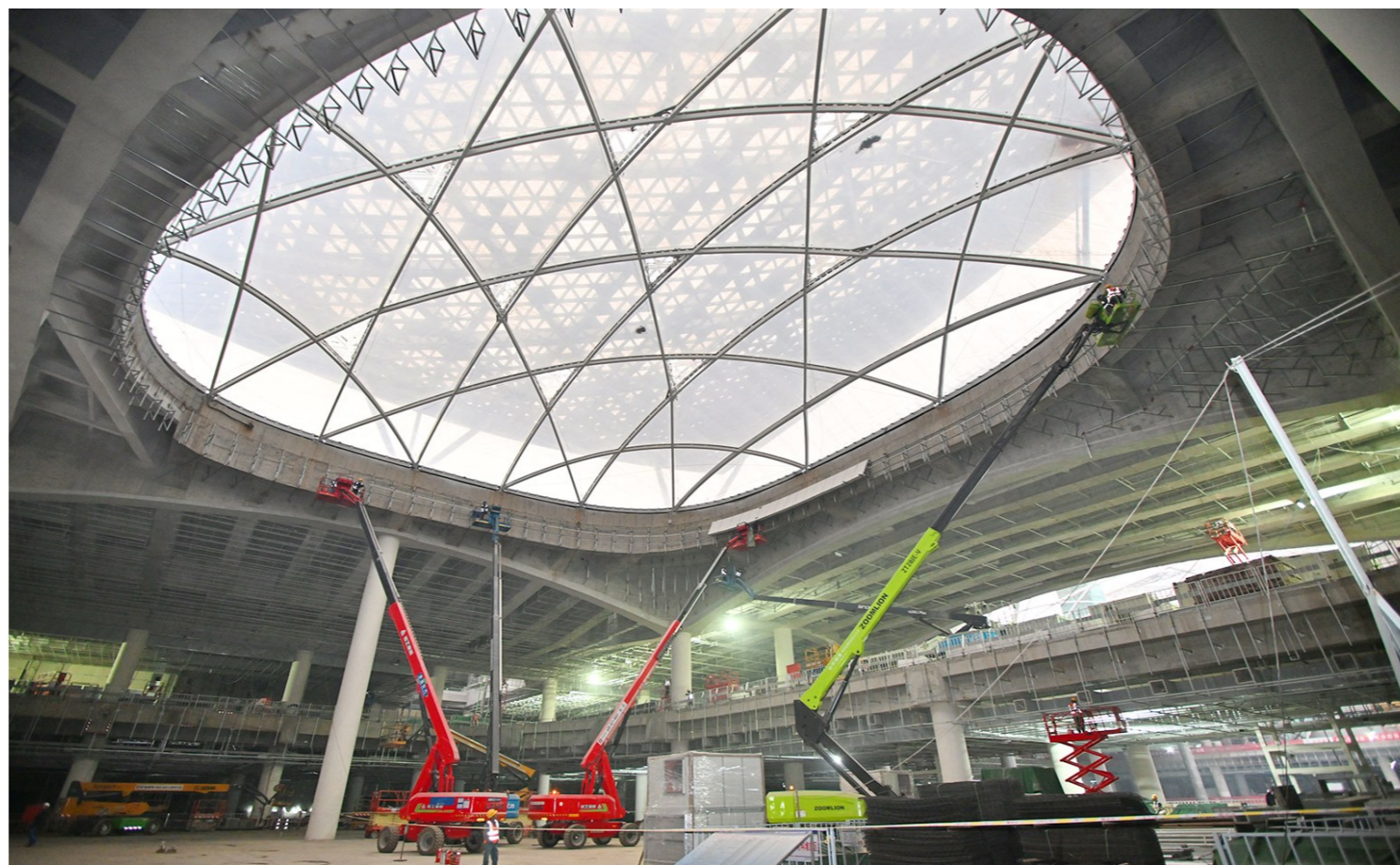
“京帆”屋盖轻扬于地面，隔热又透光，点亮了这座地下枢纽。记者 常鸣/摄
