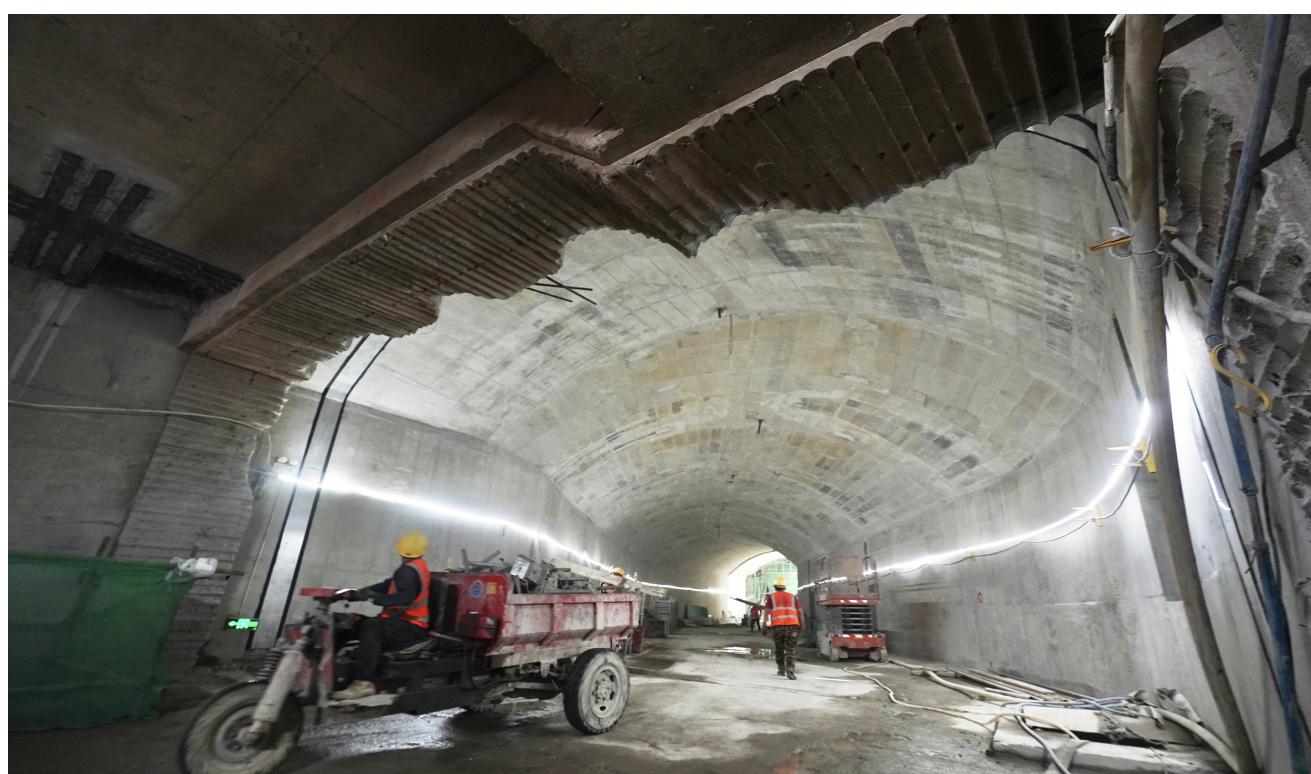
扶梯数量翻三倍! 地铁国贸站换乘通道改造完成主体结构施工,预计明年将部分投入使用。记者 程功/摄
