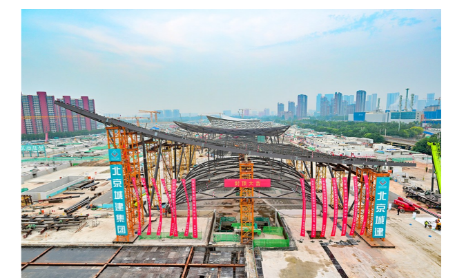
“京帆”屋盖主帆钢结构实现封顶。记者 常鸣/摄
