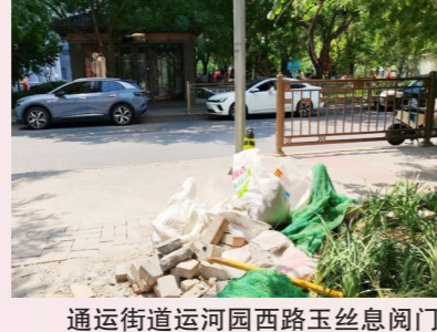
通运街道运河园西路玉丝园门对面—堆物堆料
