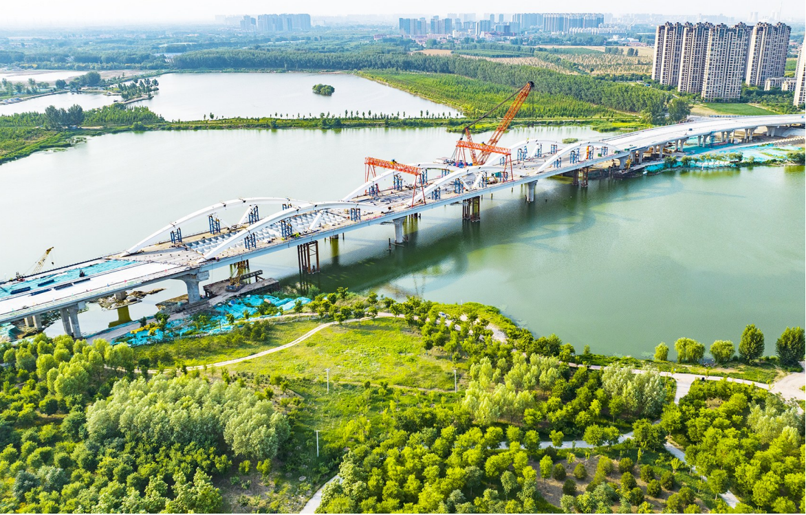
厂通路潮白河大桥即将进行桥面铺装,预计9月实现通车。记者 常鸣/摄
