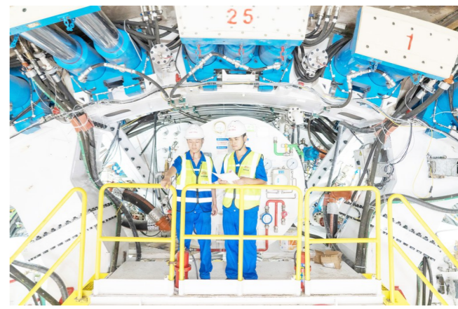
技术人员检查盾构机。(中国铁路北京局供图)
