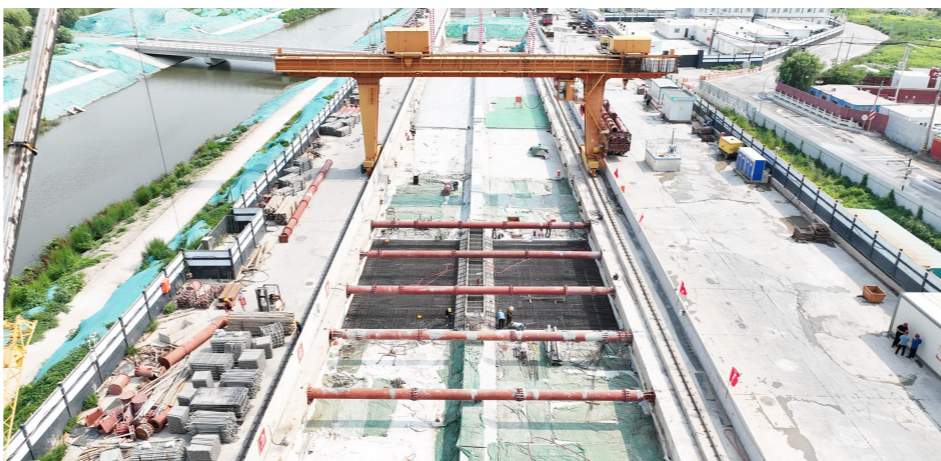
东小营南站施工现场,建设者正在灌注混凝土。记者 常鸣/摄
