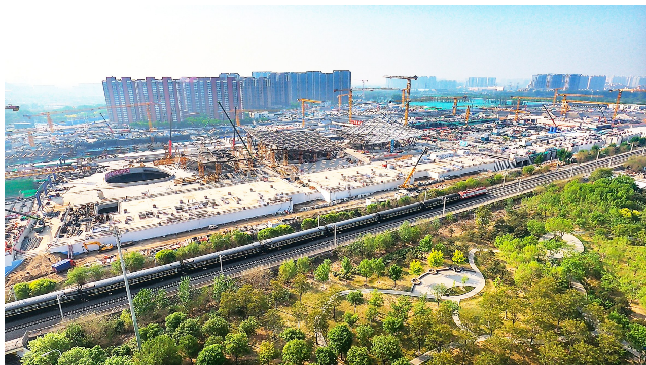
俯瞰北京城市副中心站综合交通枢纽，建设如火如荼。记者 常鸣/摄
