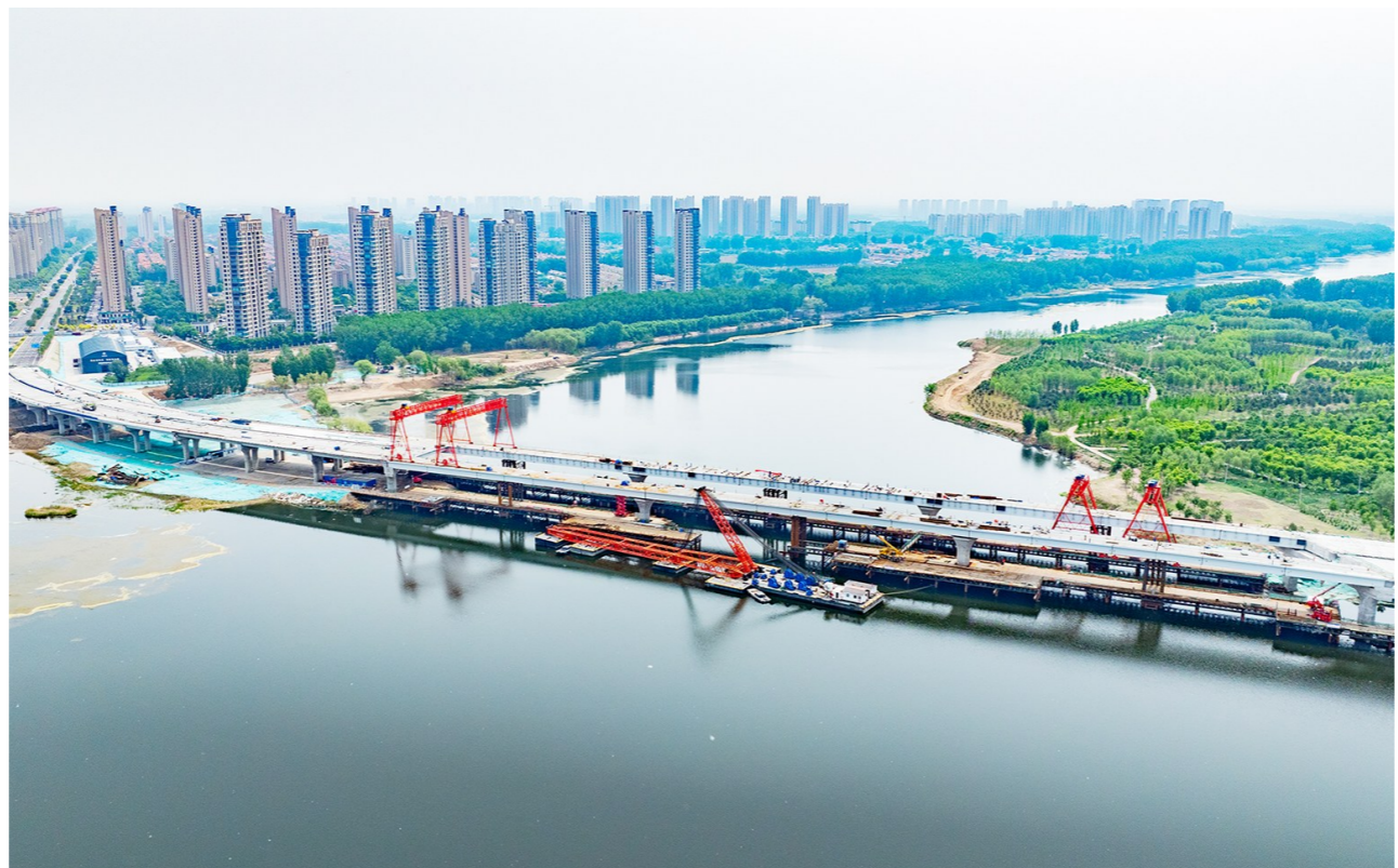
厂通路潮白河大桥跨河主桥上部结构钢梁实现双侧贯通。记者 常鸣/摄
