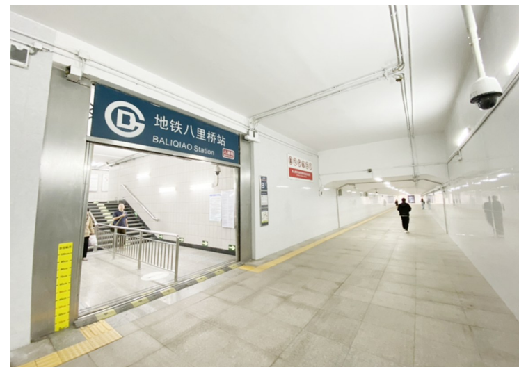
地铁八通线八里桥站B口更新改造工程完工,现已焕然一新。
