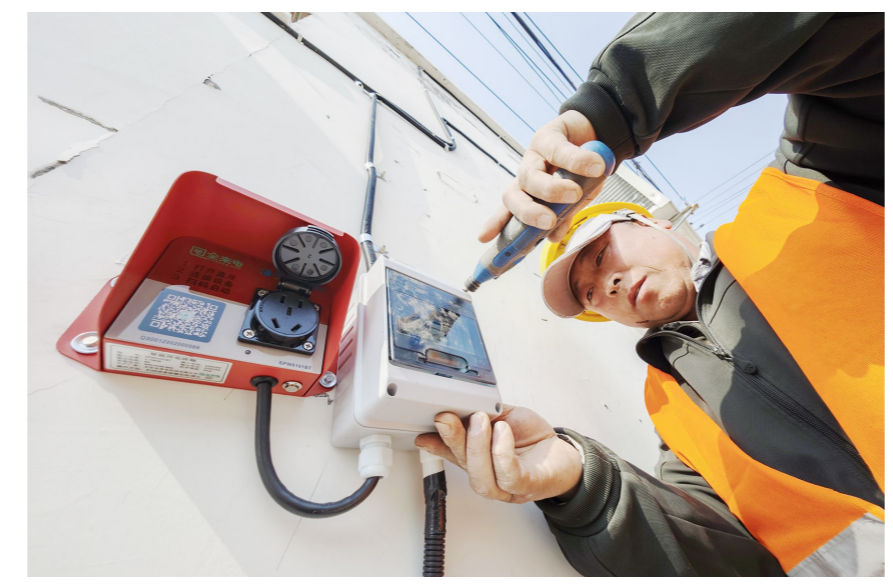
安装工人按照村民需求,将电动自行车专用充电口安装在自家院落外方便充电的位置。 记者 常鸣/摄
