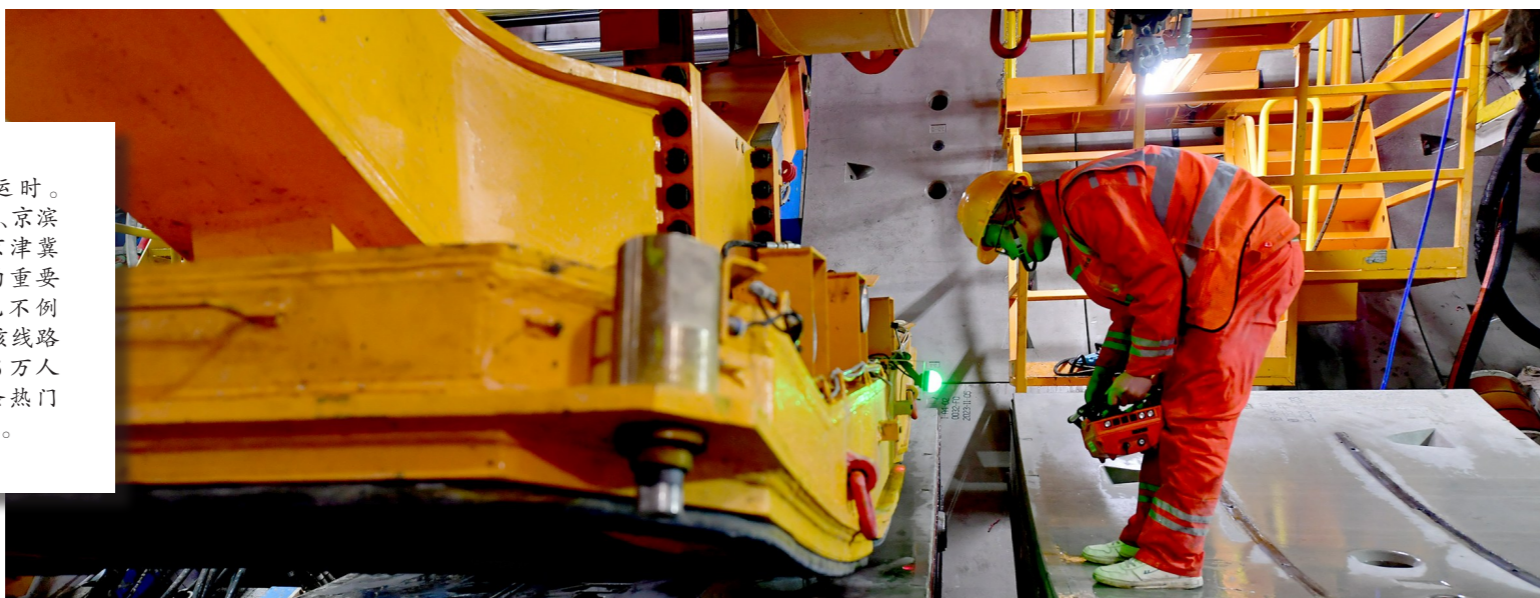
“京通号”盾构机内部，工作人员正在拼装管片。记者 常鸣/摄
