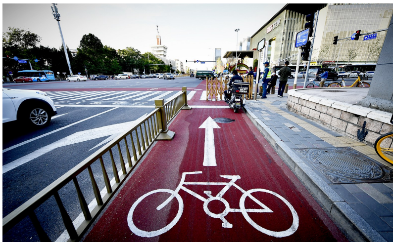
新华西街路口非机动车道。
