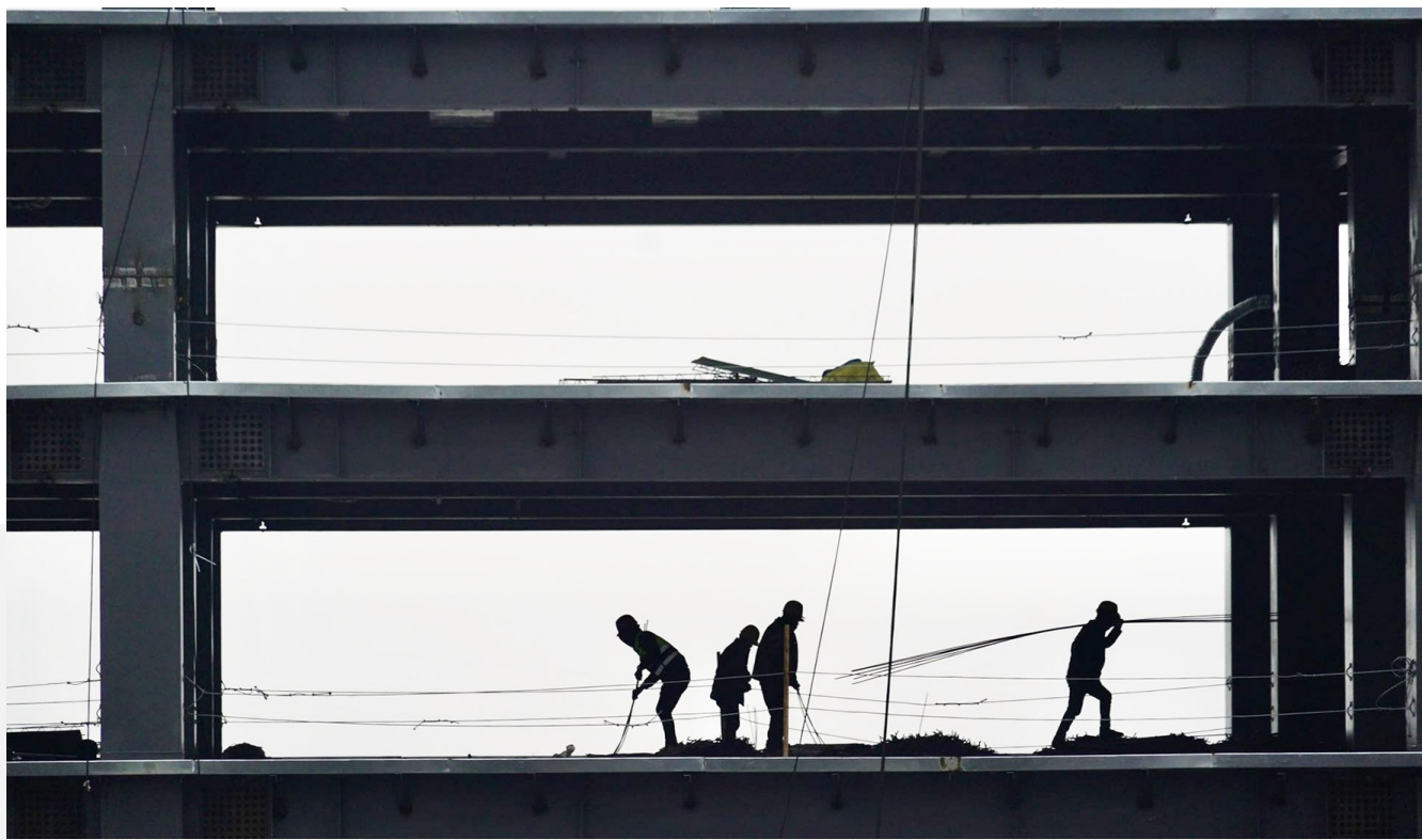
通马路综合交通枢纽主体结构封顶。程功/摄
