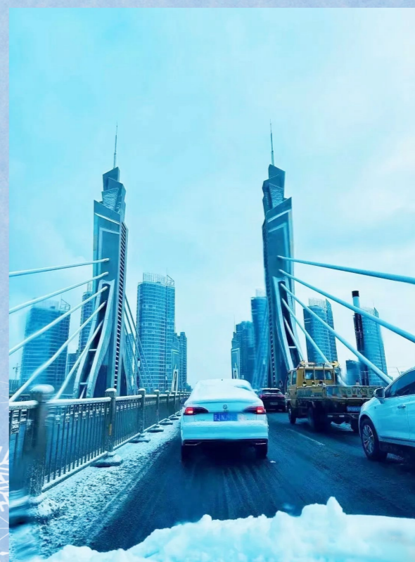
通路 上营大桥
