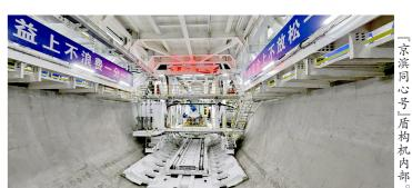
(上接1版)此外,盾构机配备了自主研发的自动导向测量系统和掘进管理系统,测量距离不小于200米,可将掘进方向误差控制在3毫米内;还配备独有超大直径盾构机长距离掘进不换刀技术,可实现在该项目全程掘进不换刀。同时,盾构机还配备了刀盘清洗及洁人装置,让盾构机边掘进边清洗,避免掘进施工出现结泥饼现象等,确保盾构机具有每天不少于6环(12米)的掘进速度。
