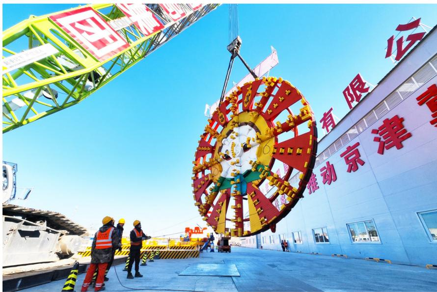
印有“瑞兔”图案的刀盘被立起，正向着盾构始发井的方向移动。
