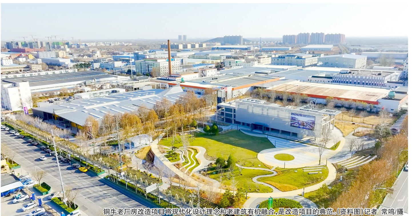
铜牛老厂房改造项目将现代化设计理念和老建筑有机融合，是改造项目的典范。（资料图）记者 常鸣/摄
