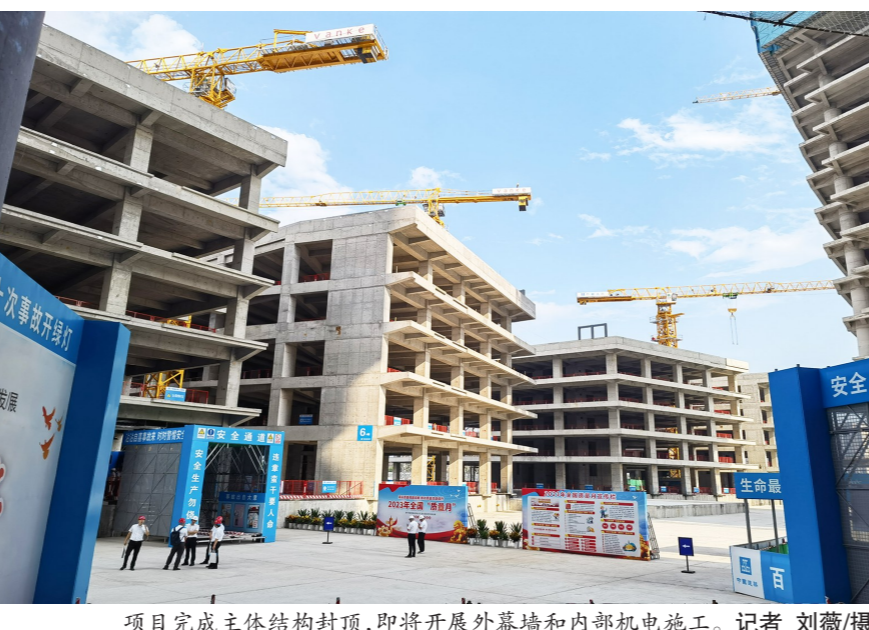
项目完成主体结构封顶,即将开展外幕墙和内部机电施工。记者 刘薇/摄
